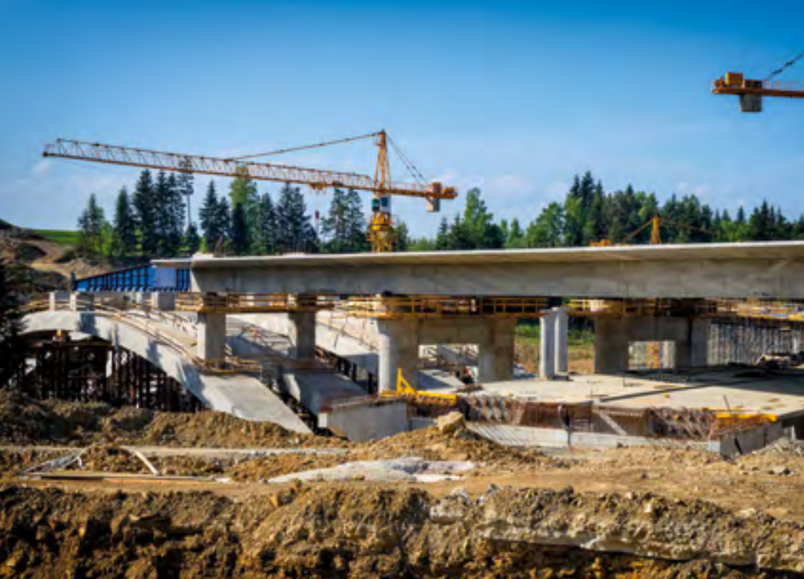
Construction d'un viaduct à Skomielna Biała (sud de la Pologne).
