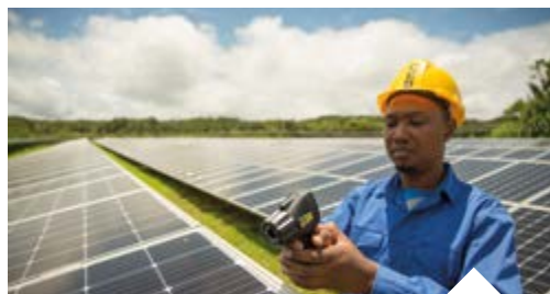
Planta fotovoltaica en Henrietta (Mauricio), con una superficie de 20.000 m 2 y 5.900 paneles.
