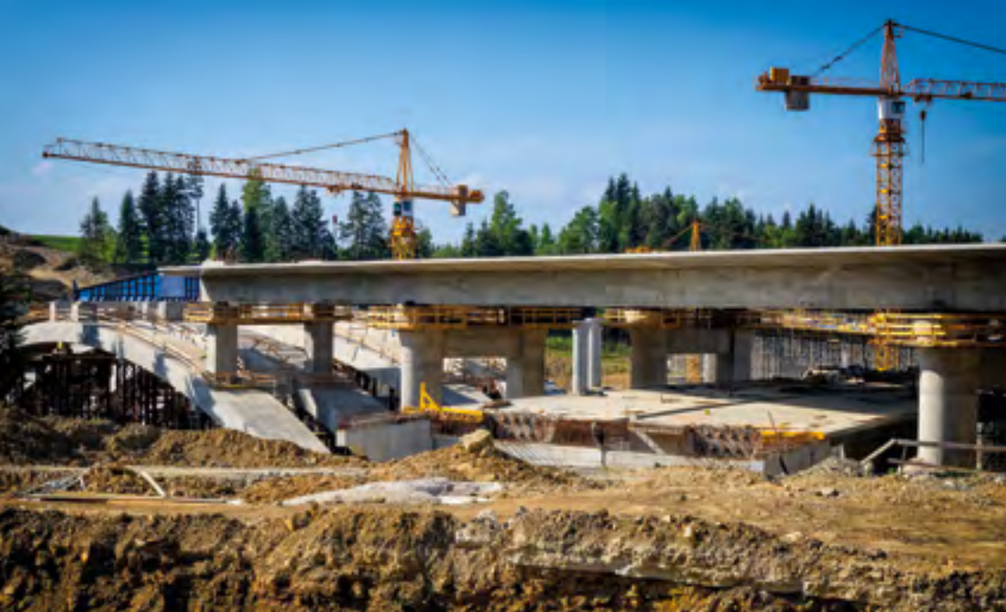
Construcción de un viaducto en Skomielna Biała en el sur de Polonia.
